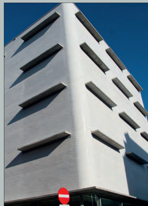
De meeste archiefopslagruimten van het nieuwe Rijksarchief bevinden zich ondergronds. © ARA
