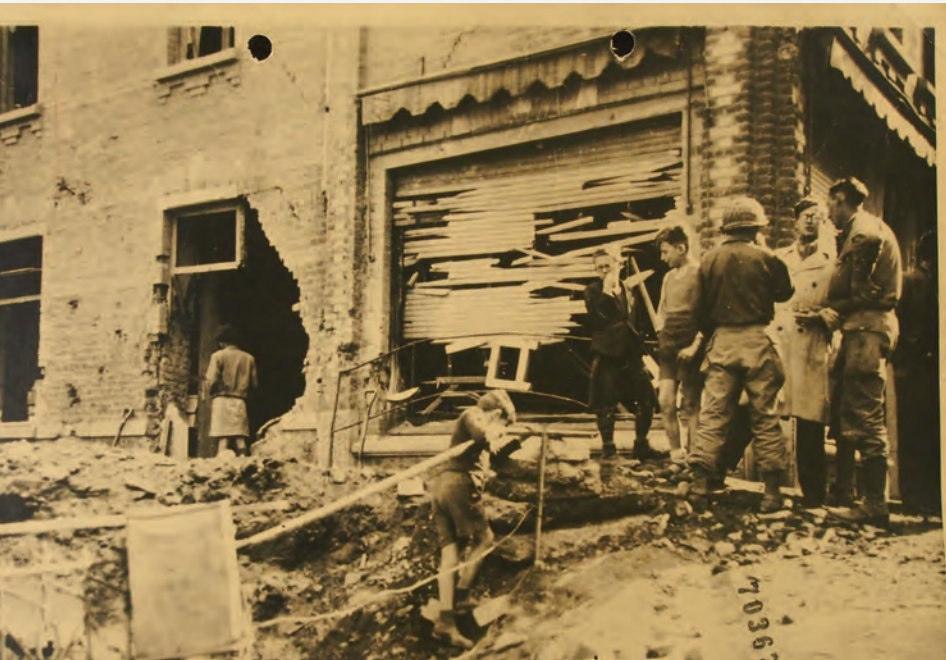
Schade aan een handelshuis in de rue du Pont te La Roche-en-Ardenne, veroorzaakt tijdens het Von Rundstedt-offensief van december 1944. Algemeen Rijksarchief 2-depot, Joseph Cuvelier (Ministerie van Wederopbouw, Archief van het Bestuur der Oorlogsschade aan private goederen, provinciale reeks, provincie Luxemburg). © ARA
