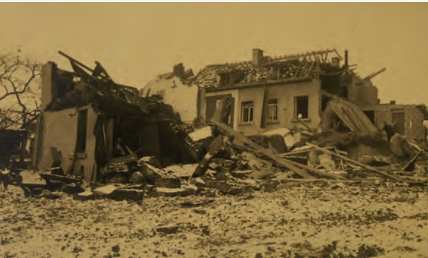
Huis in de avenue Gevaert te Genval, vernield door een bombardement op 26 januari 1945. Algemeen Rijksarchief 2-depot Joseph Cuvelier (Ministerie van Wederopbouw, Archief van het Bestuur der Oorlogsschade aan private goederen, provinciale reeks, provincie Brabant). © ARA
