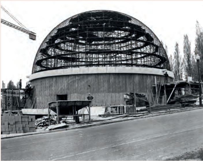
Bouw van het nieuwe planetariumgebouw in 1974.
